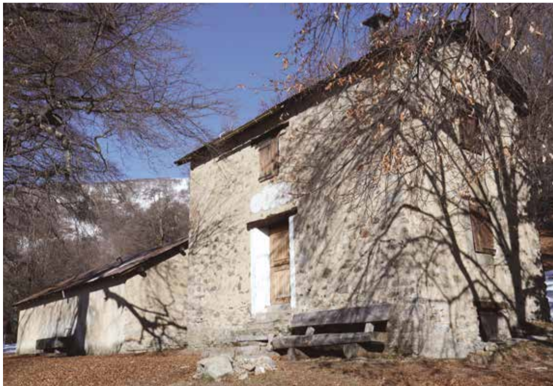
La Casera di Cima Pianca sarà resa abitabile con 5/6 posti letti. Gli edifici saranno tutti ristrutturati.
